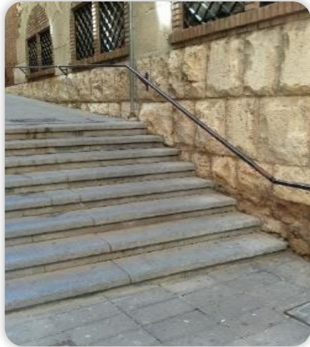
Imagen 1. Escaleras para entrar a un edificio.
